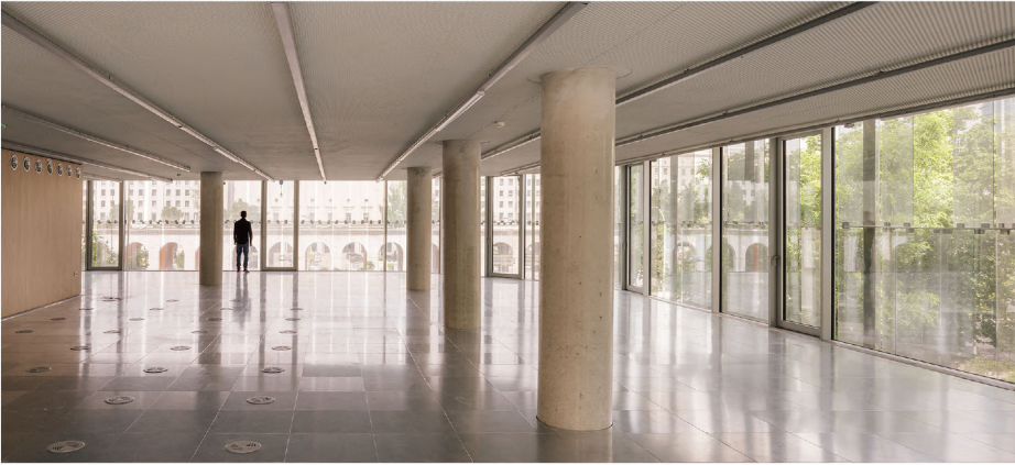
PLANTAS TIPO CON LOSA ACTIVA DE HORMIGÓN VISTO Y DOBLE PIEL TRANSPARENTE
