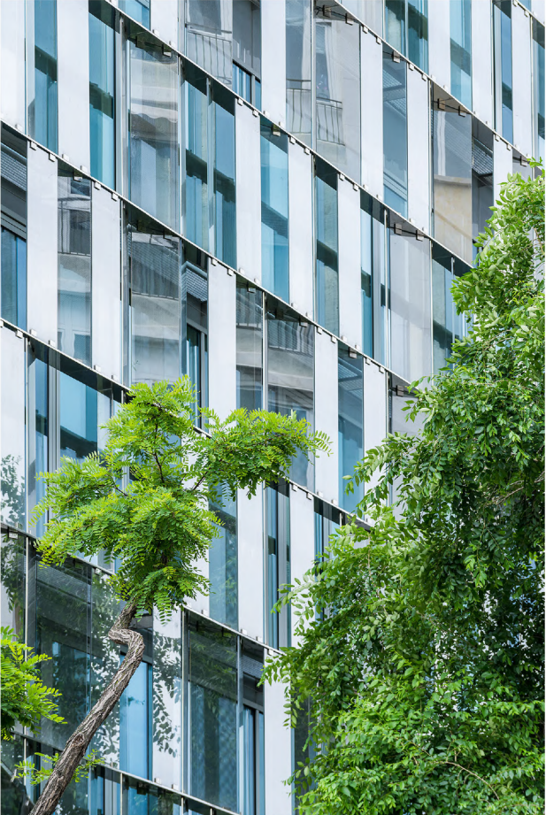
DETALLE REFLEJOS FACHADA DESDE LA CALLE JORGE MANRIQUE
