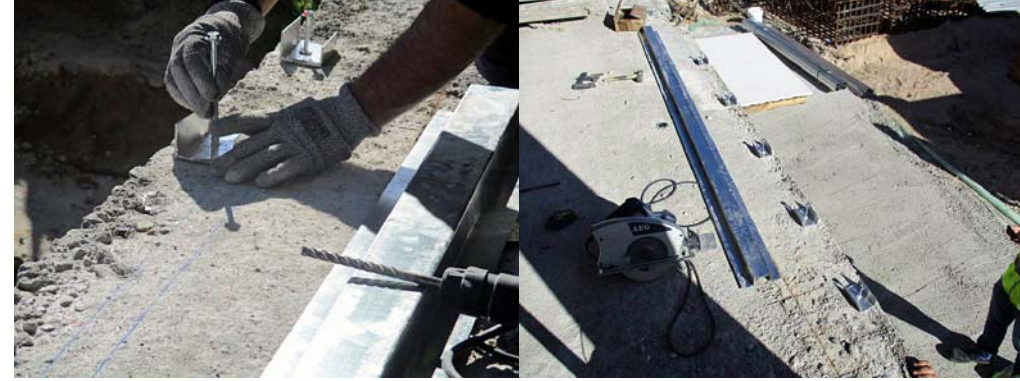
CASQUILLOS U PARA NIVELACIÓN DE PERFIL OMEGA EN LA CARA SUPERIOR DEL FORJADO.
