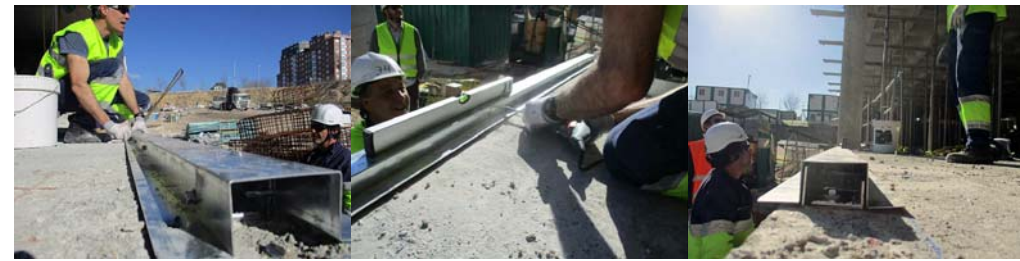
PERFIL OMEGA Y NIVELACIÓN EN LA CARA SUPERIOR DEL FORJADO.
