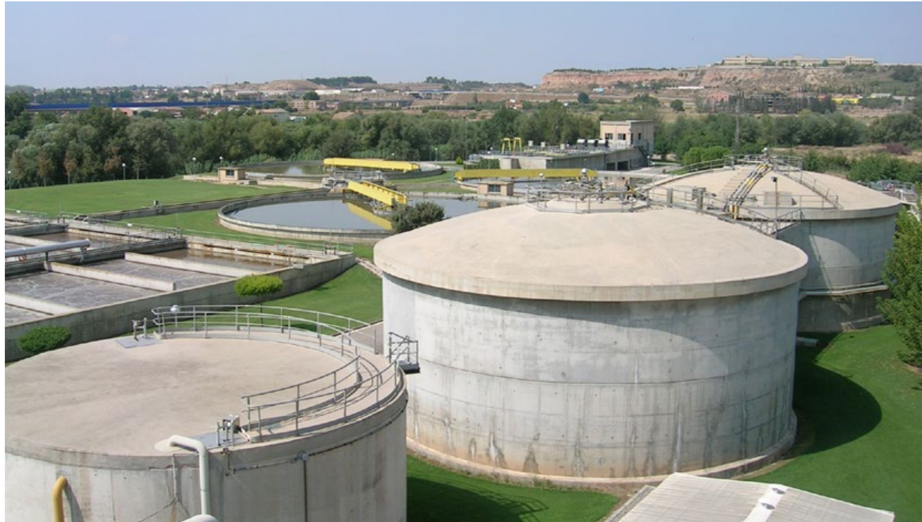
Estación Depuradora de Aguas Residuales (EDAR) de Lleida, primer servicio de agua que certifica su Huella de Carbono 0 en España por AENOR.
