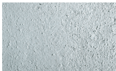
Mano de fondo y relleno de fisuras con KEIM ContactPlus-Grob
